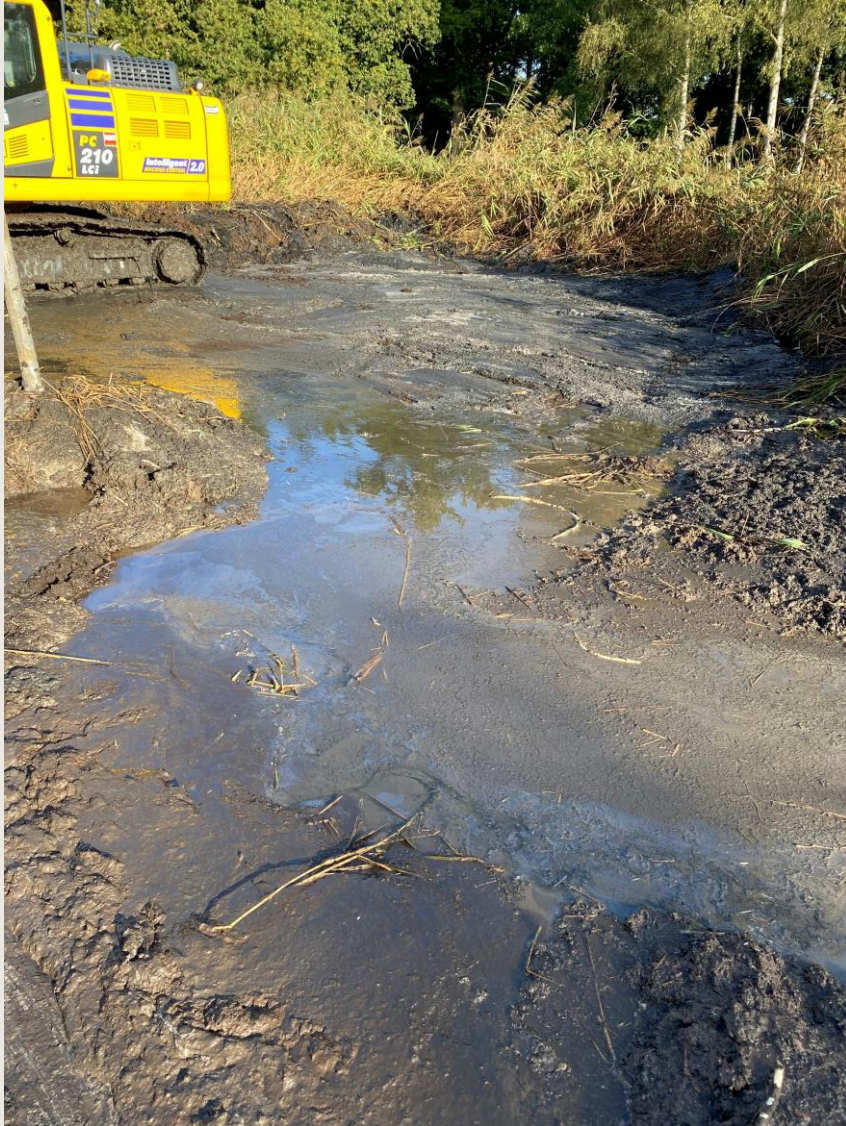
Schwierige Räumung Beet 3, September 2024
