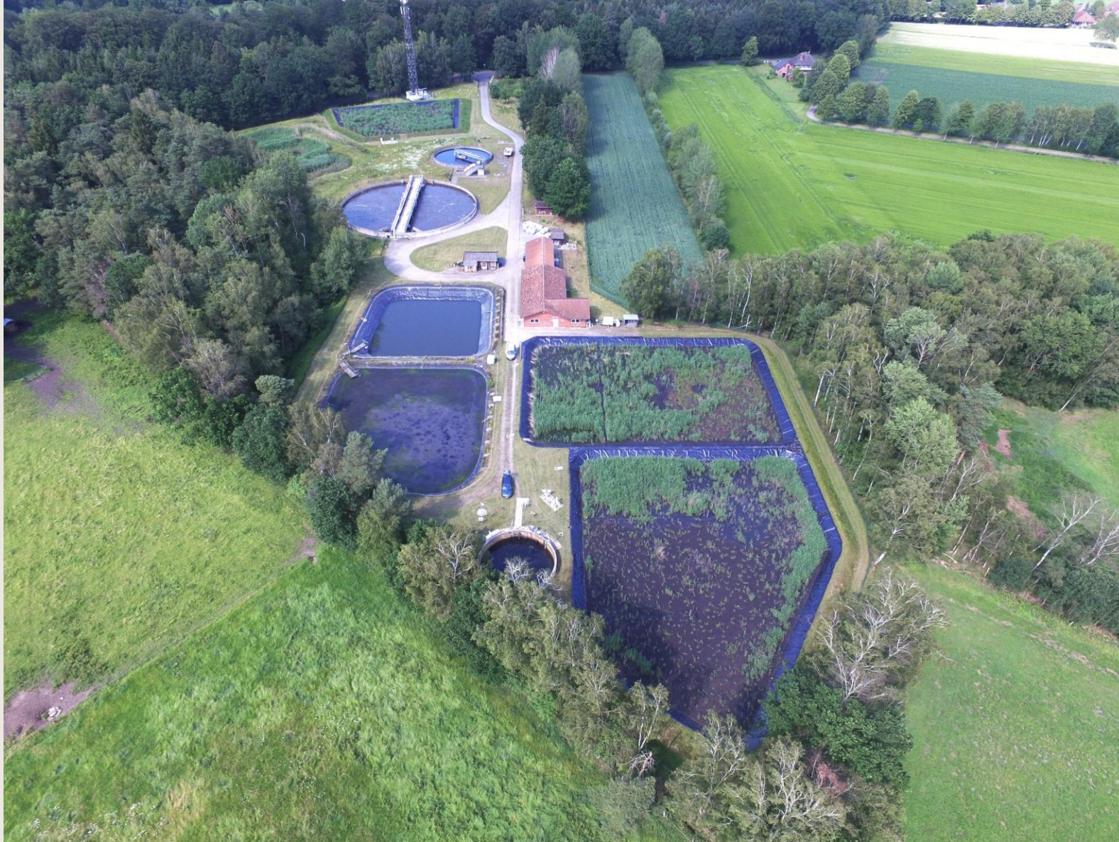
Juni 2019: 3 Beete, stark belastete Anlage, schwierige Schlammqualität
