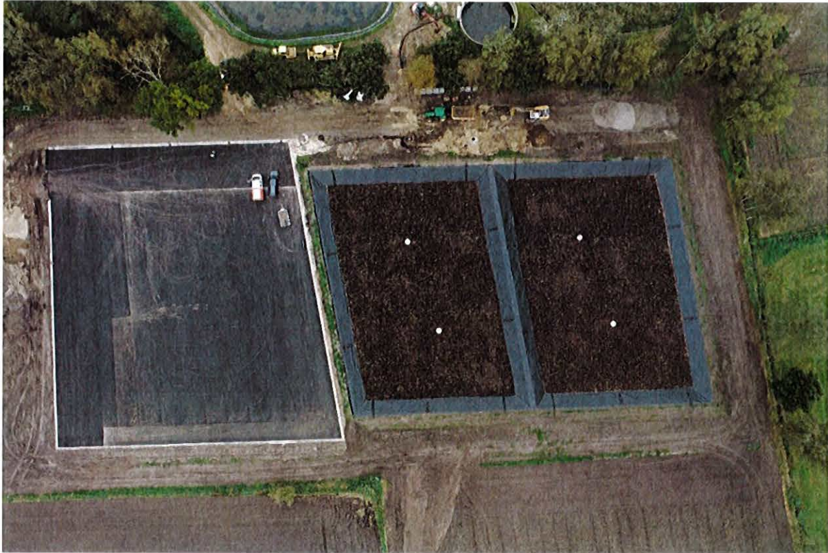
Abbildung 4: Drohnfoto kurz vor Abschluss der Bauarbeiten vom 05.10.2021. Rechts im Bild sind die beiden neuen Beete 4 und 5 zu sehen, auf der linken Seite die Nachlagerfläche, auf der nach Räumungen das ausgebaute Material zwischengelagert werden kann.
