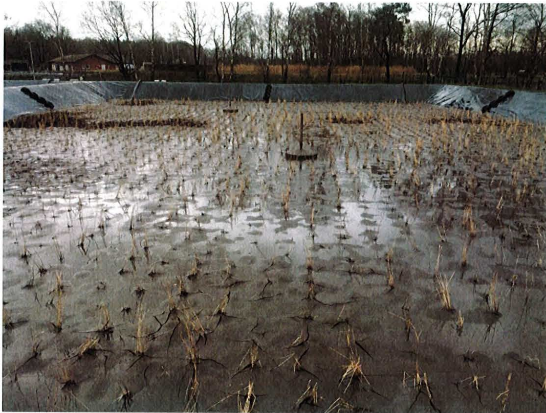
Abbildung 5: Beet 5 am 01.12.2021 nach der ersten Beschickung. Man erkennt schön die gleichmäßigen, dichten Pflanzreihen und die ebenfalls gleichmäßige Verteilung des Klärschlammes. Nur wenige, etwas höher gelegene Bereiche wurden noch nicht mit Schlamm überdeckt.
